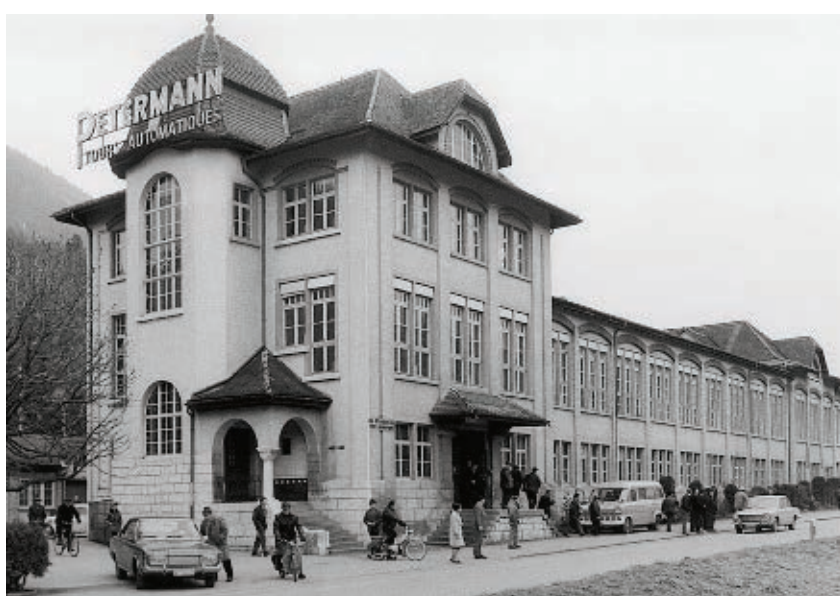
Aujourd'hui, le bâtiment de l'usine Petermann loge artistes, salles de sport, bureaux ou locaux commerciaux. MUSÉE DU TOUR
