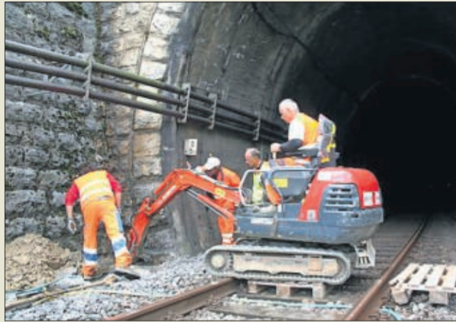
Creuser aussi vite que possible entre le passage de deux trains.
