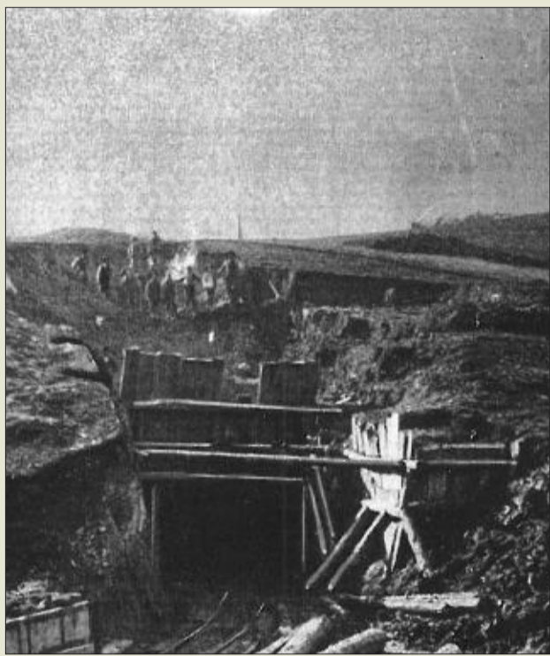
Une vue de l'entrée du tunnel côté Moutier, au début des travaux...
