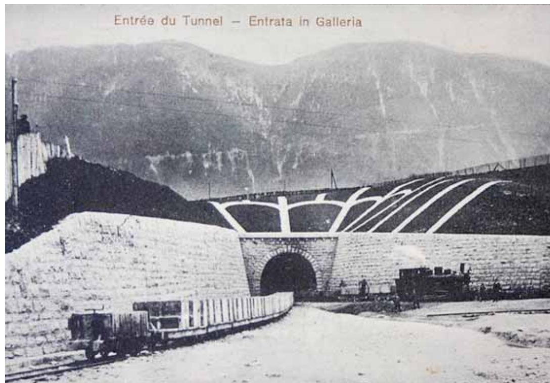
L'entrée nord du tunnel, côté Moutier, telle qu'elle apparaissait en 1915, au moment où l'ouvrage a été ouvert au trafic ferroviaire.
