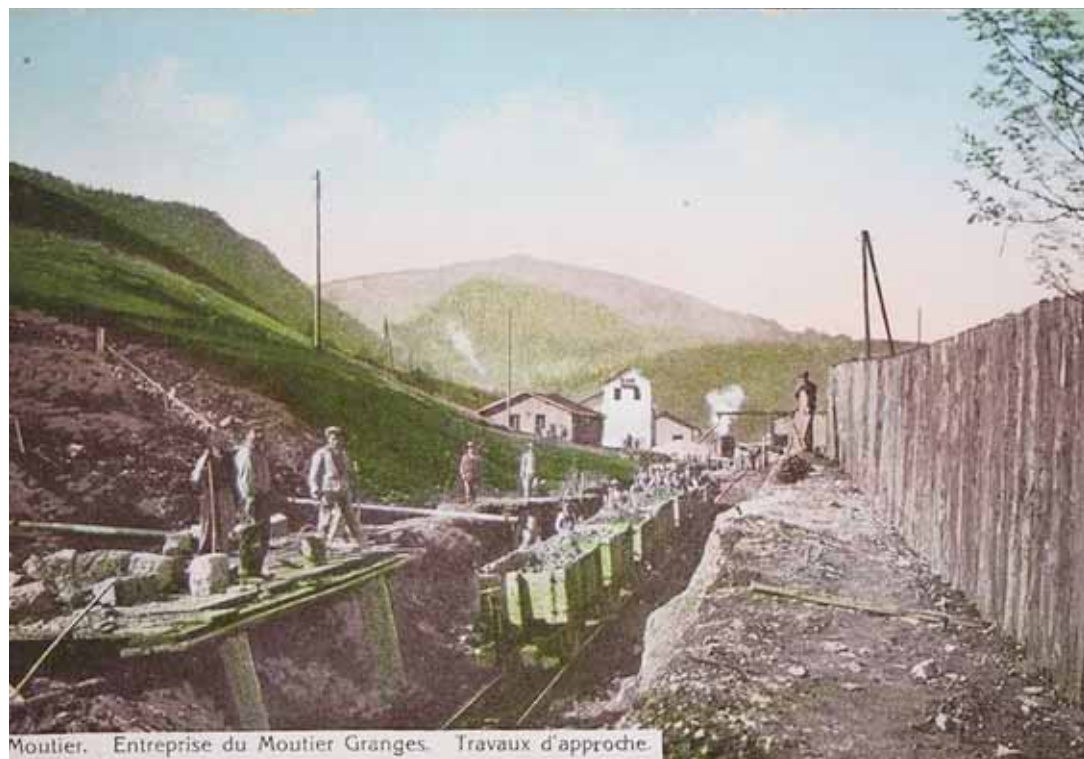
Peut-on imaginer, en observant cette vue d'ouvriers au travail, qu'ils participent à la construction d'un axe reliant Paris à Milan? PHOTOS MUSÉE DU TOUR AUTOMATIQUE ET D'HISTOIRE, MOUTIER
